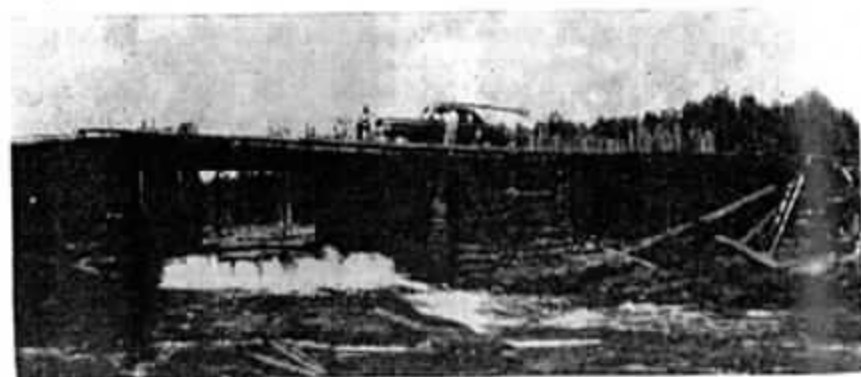
Le barrage du Gilardo, sur la rivière Vermillon. L'auto-passe sur le barrage, comme sur un pont.
